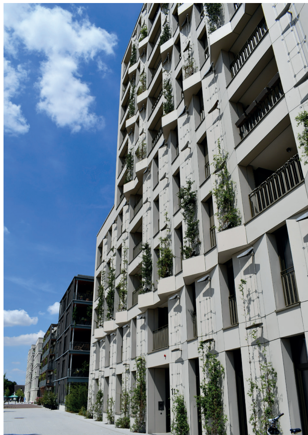
Abb. 13: Wandgebundene Fassadenbegrünung in Regalbauweise (horizontal). Quelle: BuGG
